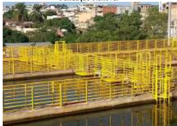
Figura 34 - ETA Central após intervenção da Fundação Renova.
