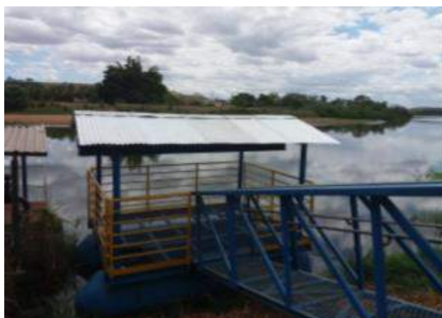
Figura 37 - Construção de nova balsa de captação.
