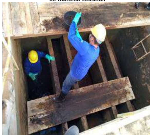
Figura 63 - Impermeabilização dos filtros com a troca do material filtrante.
