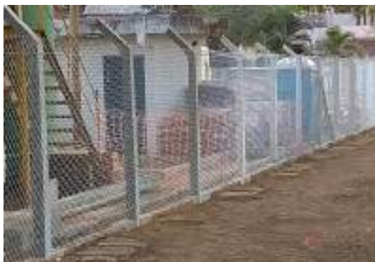
Figura 53 - Cercamento da área da ETA.
