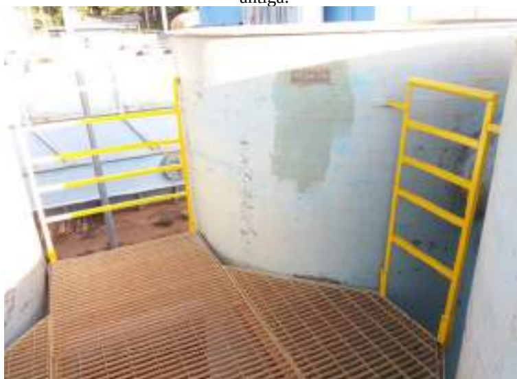
Figura 31 - Fabricação e montagem de uma nova plataforma de acesso à área de tratamento, substituindo a antiga.
