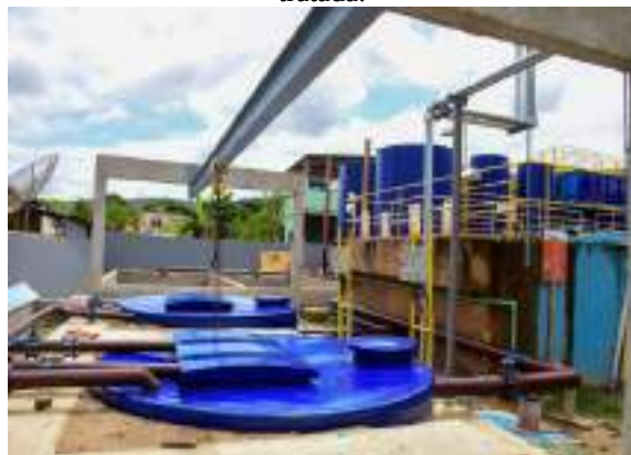
Figura 22 - Revitalização do reservatório de água tratada.
