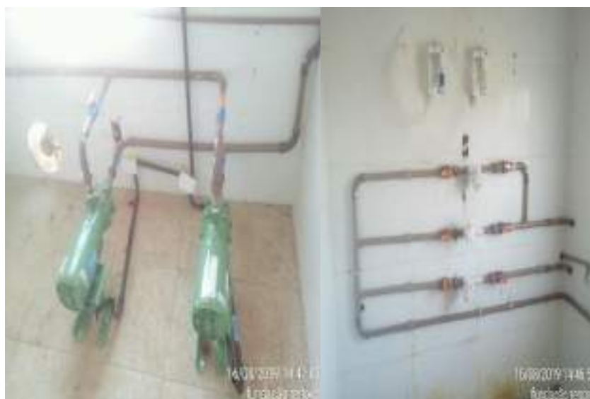
Figura 61 - Reforma do sistema de cloro gasoso.
