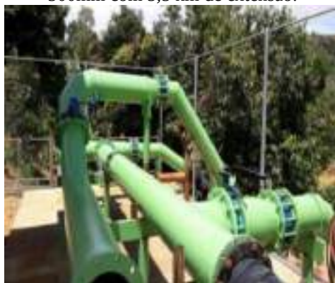
Figura 19 - Adutora de água bruta de PEAD DN 500mm com 5,5 km de extensão.
