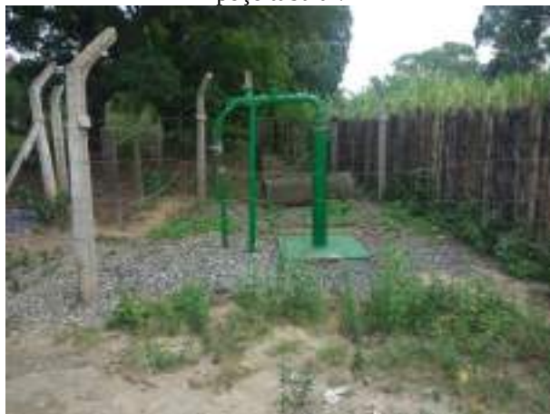
Figura 64 - Captação alternativa, independente do rio Doce, com a perfuração e instrumentação de um novo poço tubular.
