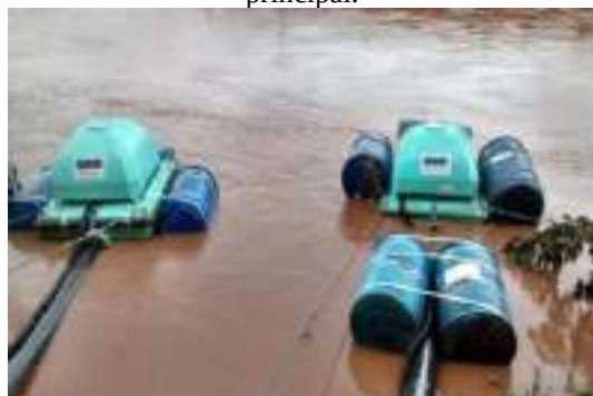
Figura 10 - Instalação dos flutuantes na captação principal.
