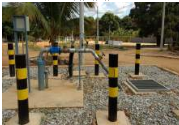
Figura 23 - Poços instrumentados como captação alternativa.
