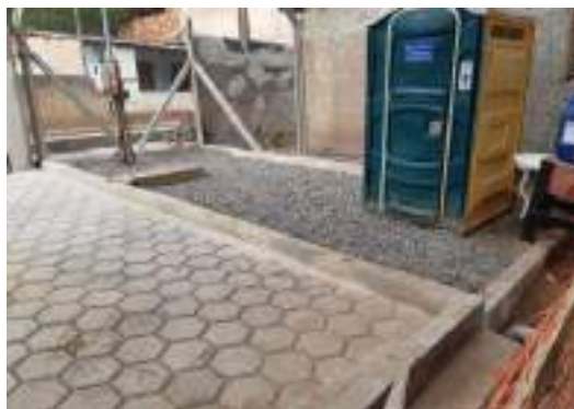
Figura 51 - Nivelamento de piso.
