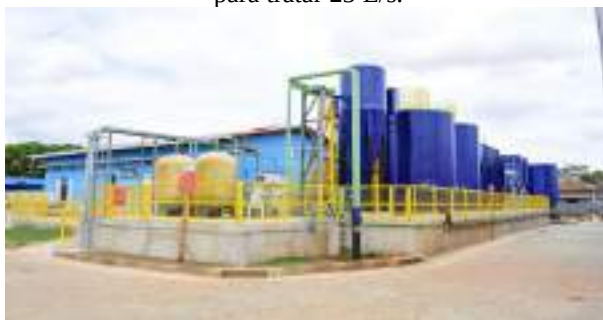
Figura 20 - Nova ETA, compacta, com capacidade para tratar 25 L/s.
