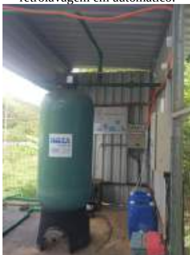
Figura 66 - Filtro de zeólitas com sistema de retrolavagem em automático.
