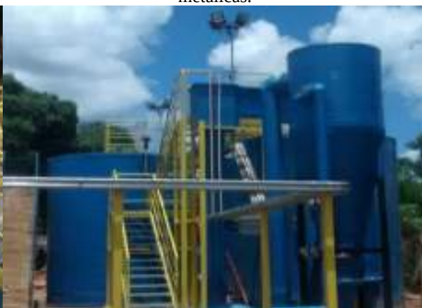
Figura 5 - Nova ETA modular e melhorias estruturais metálicas.
