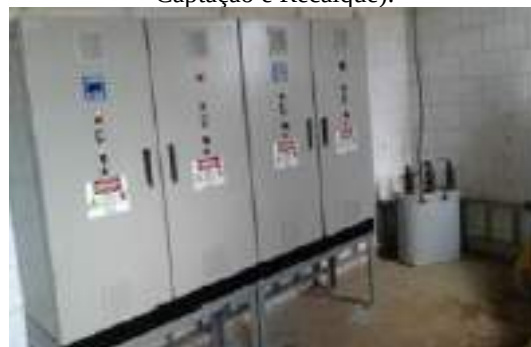
Figura 11 - Painéis com Inversores (Bombas da Captação e Recalque).
