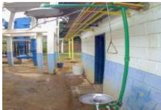
Figura 9 - Reforma das instalações acessórias.
