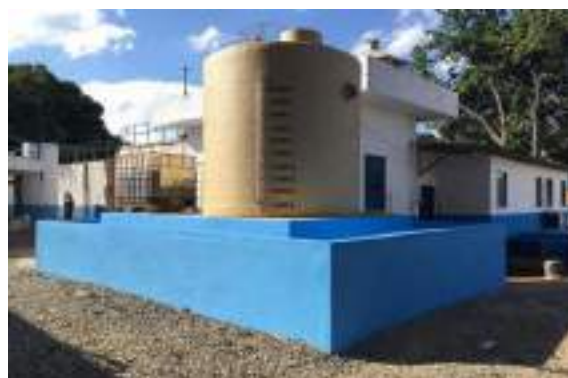
Figura 7 - Construção de contenção de químicos.
