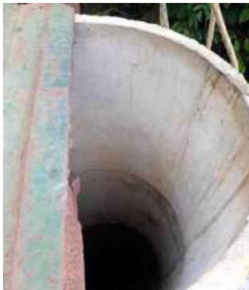
Figura 70 – Amostragem realizada em SAI.
