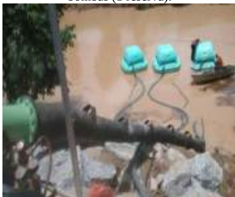
Figura 18 - Três conjuntos de flutuantes com duas bombas (1 reserva).
