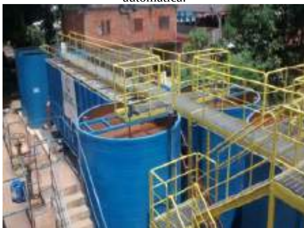
Figura 4 - Construção de nova ETA modular automática.
