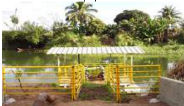
Figura 26 - Fabricação, instalação e pintura de guarda-corpos nas áreas da ETA, reservatório e captação.
