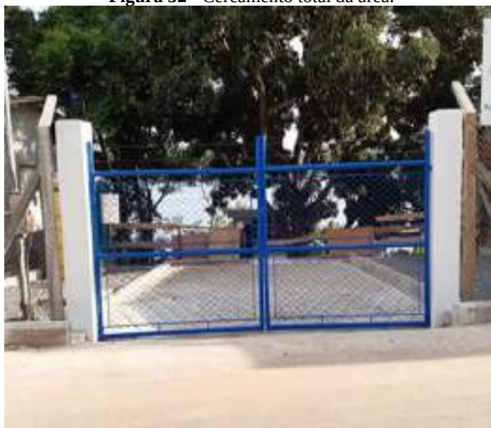
Figura 52 - Cercamento total da área.
