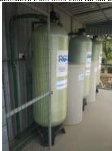
Figura 67 - Dois abrandadores com regeneração em automático e um filtro com carvão ativado.
