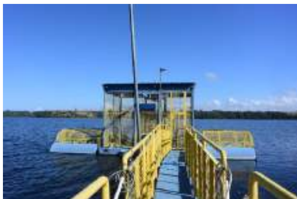
Figura 40 - Balsa com 3 bombas, sendo 1 reserva.
