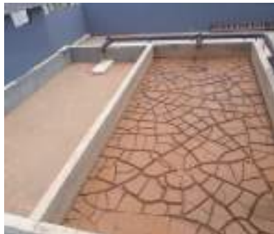
Figura 24 - Unidade de tratamento de resíduo - UTR.
