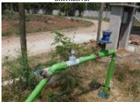
Figura 46 - Fundação Renova forneceu um poço profundo com capacidade de 6,7 L/s como captação alternativa.
