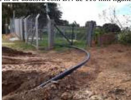
Figura 49 - Construção de 750 m de adutora com DN de 110 mm ligando a captação alternativa à ETA.
