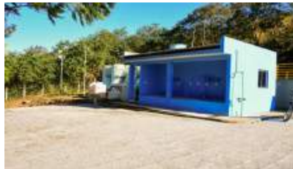
Figura 27 - Adequações na casa de químicos.
