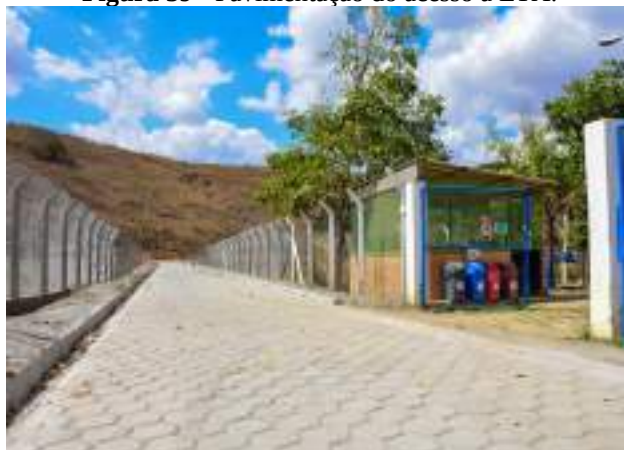
Figura 39 - Pavimentação do acesso à ETA.
