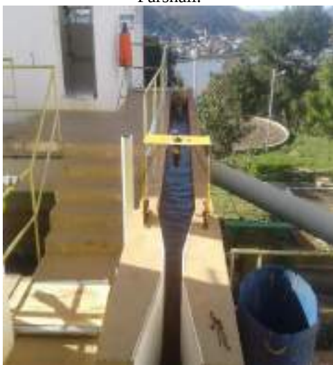
Figura 62 - Instalação de medidor de vazão na calha Parshall.
