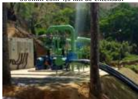
Figura 17 - Adutora de água bruta de PEAD DN 500mm com 4,0 km de extensão.
