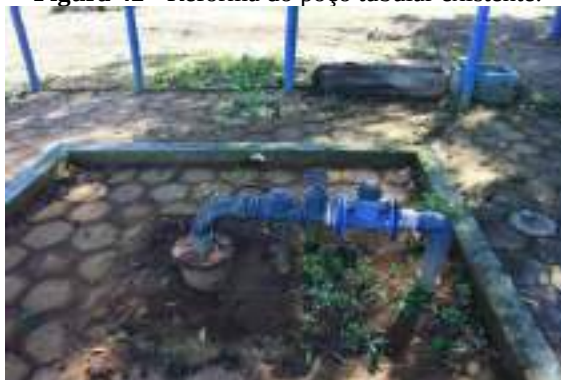
Figura 42 - Reforma do poço tubular existente.
