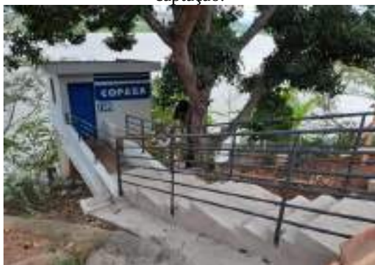
Figura 50 - instalação de guarda-corpo para segurança dos operadores e pintura do prédio da captação.
