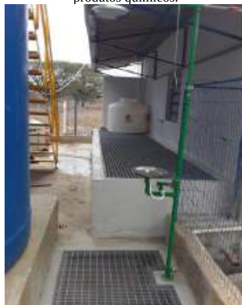
Figura 36 - Construção de contenção para produtos químicos.
