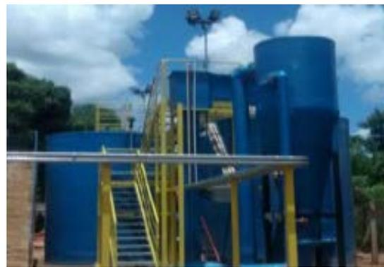
Além da construção da nova ETA modular, a Fundação Renova realizou melhorias em estruturas metálicas e dispositivos, obras civis na ETA (Figura 3), reforma das instalações acessórias (laboratório e casa de químicos) (Figuras 5 e 6), adequação elétrica da ETA e da casa de químicos, construção da baia de produtos químicos (Figura 4) e fornecimento do diagnóstico do sistema de tratamento com aprovação da COPASA.
