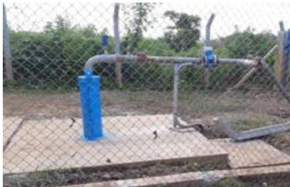
A Fundação Renova executou obras no poço para atendimento dos padrões da COPASA, como urbanização e cercamento da área (Figura 39), construção de novo padrão de energia (Figura 40) e a construção de 750 m de adutora com diâmetro de 110 mm, ligando a captação alternativa ao novo STA do poço (Figura 41).
