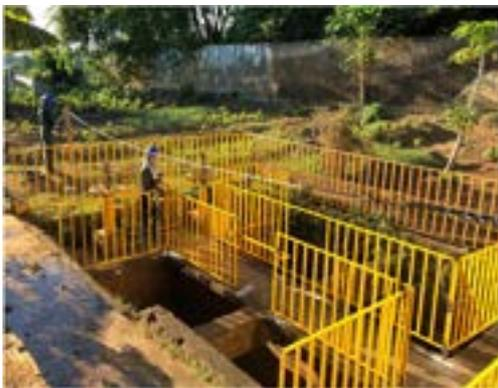
Figura 26 - Fabricação e instalação de guarda-corpos no reservatório, área da captação e fosso das bombas.
