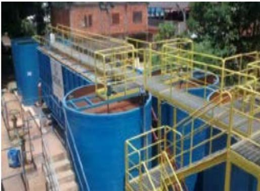
Figura 2 - Nova ETA modular e melhorias estruturais metálicas.
