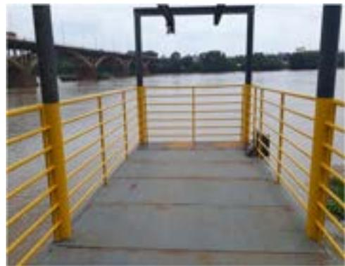
Figura 27 - Fabricação e montagem de uma nova plataforma de acesso à área de tratamento, substituindo a antiga.
