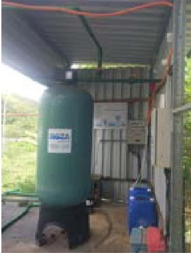
Figura 59 - Dois abrandadores com regeneração em automático e um filtro com carvão ativado.
