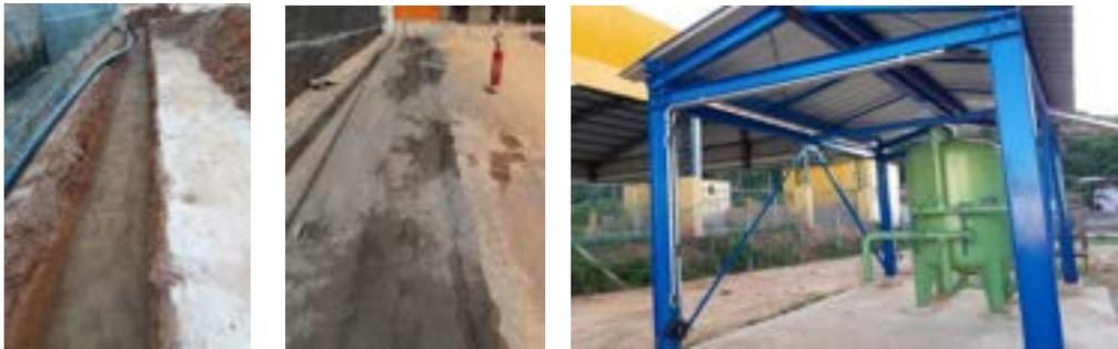
Na captação principal, obras foram executadas, como pavimentação, instalação de guarda-corpo para segurança dos operadores, nivelamento de piso, pintura do prédio da captação e cercamento total da área. As Figuras 42, 43 e 44 mostram as melhorias executadas.
