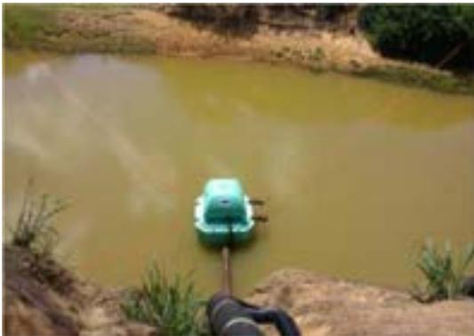
Figura 14 - Adutora de água bruta de PEAD DN 500mm com 4,0 km de extensão.
