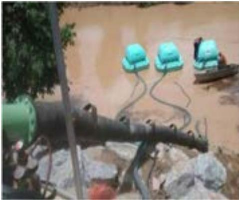
Figura 16 - Adutora de água bruta de PEAD DN 500mm com 5,5 km de extensão.
