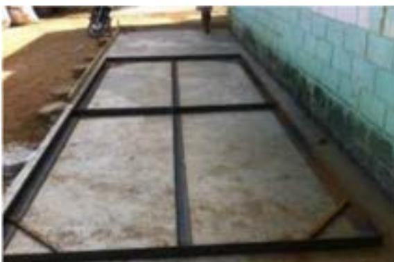
Figura 4 - Construção de contenção de químicos.
