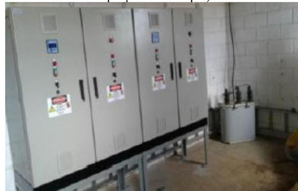
Figura 9 - Painéis de distribuição 220V e 440V.
